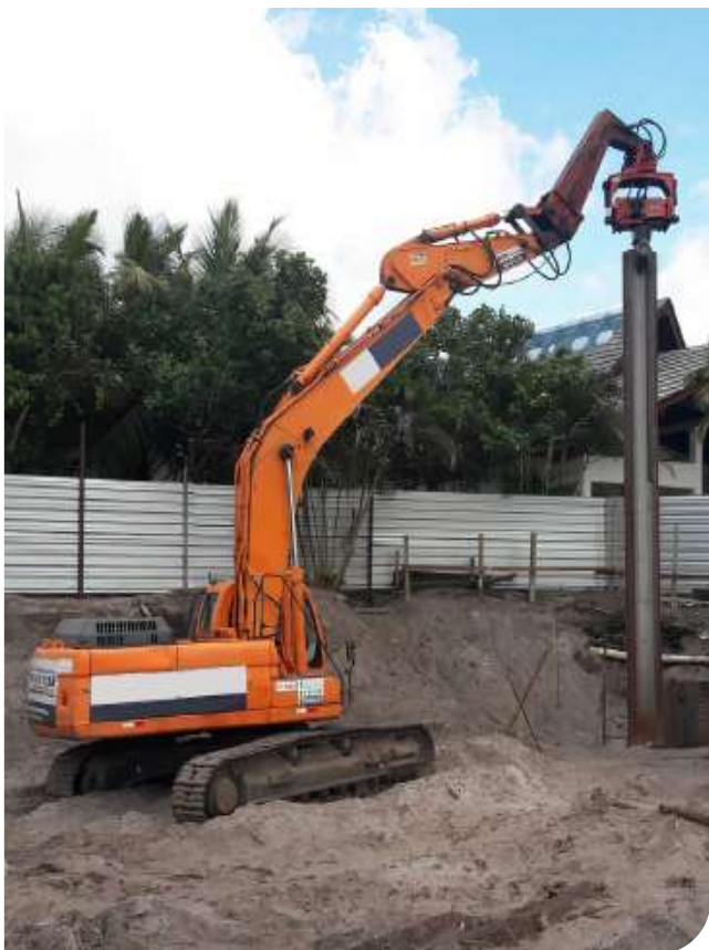
Martelo vibratório acoplado em escavadeira
