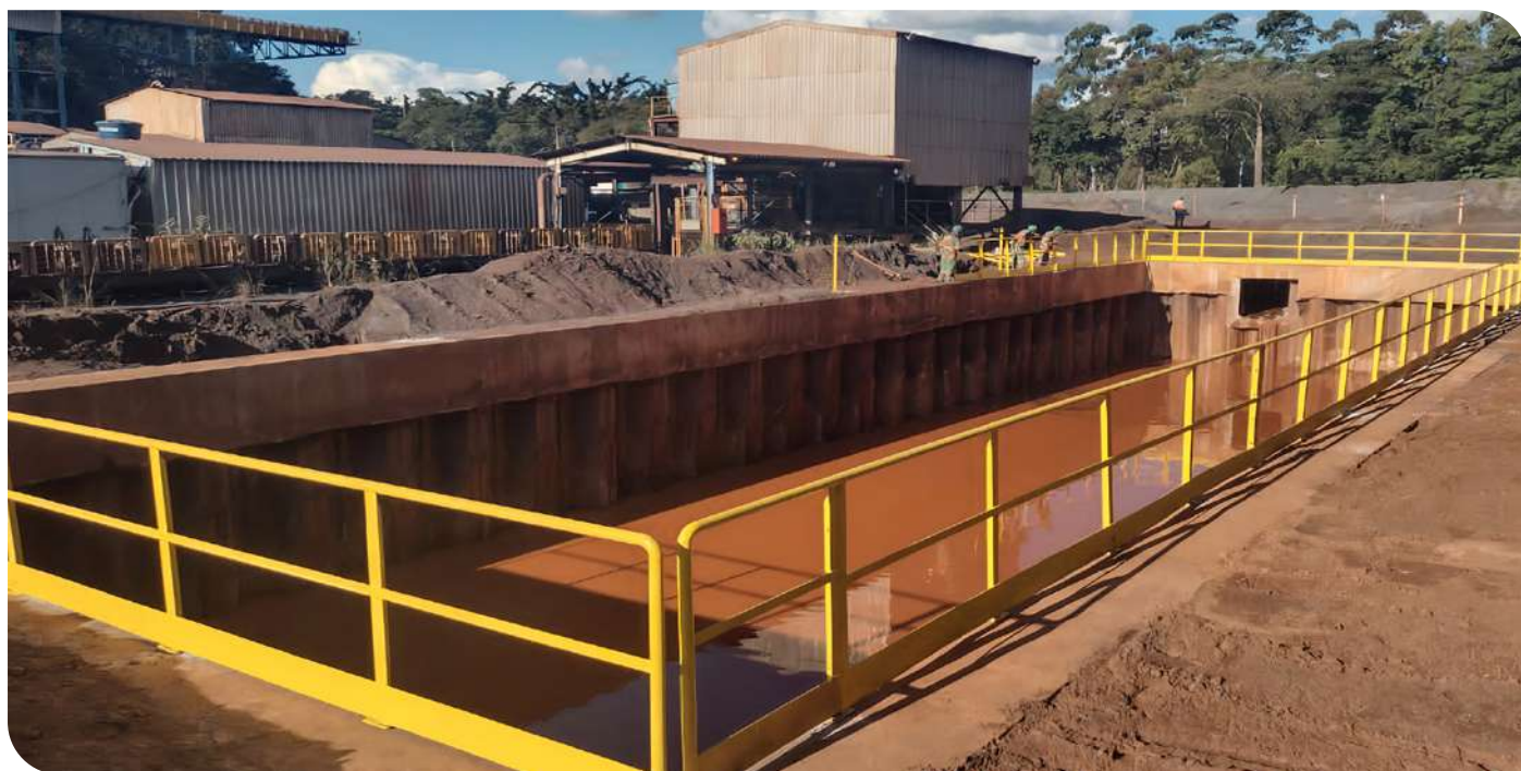
Sump Local: Itabira, MG Produto: AZ® 19-700
