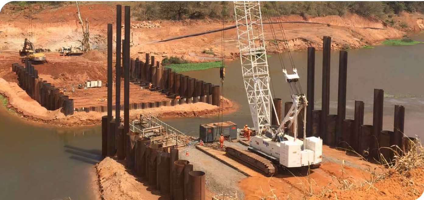
Contenção de rejeitos Local: Rio Doce, MG
