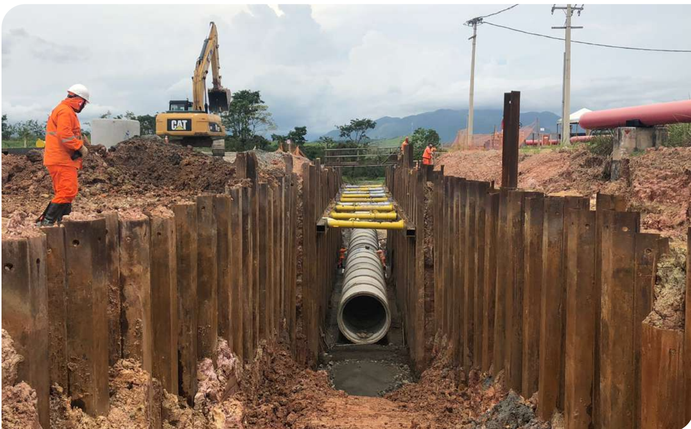
Escoramento de Vala Local: Itaboraí, RJ
