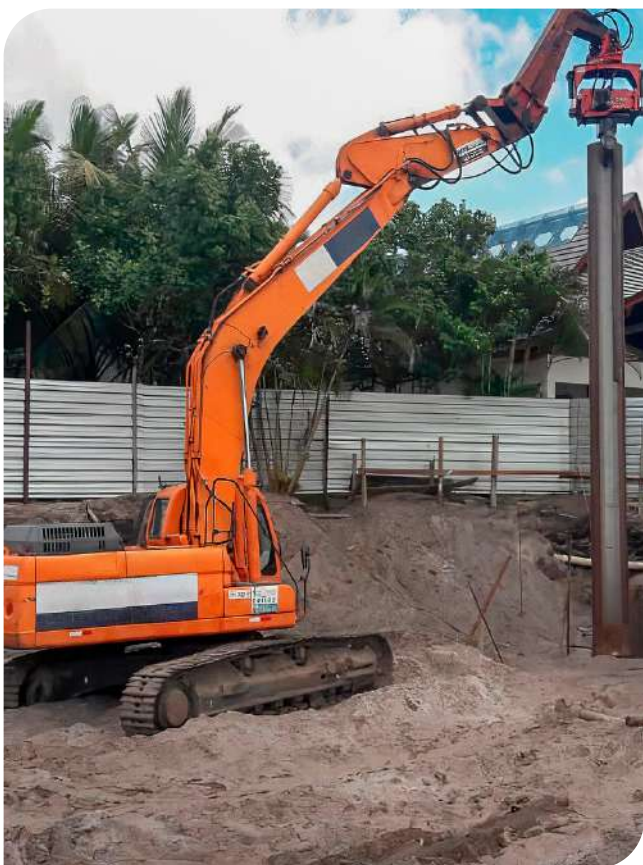
Martelo vibratório acoplado em escavadeira
