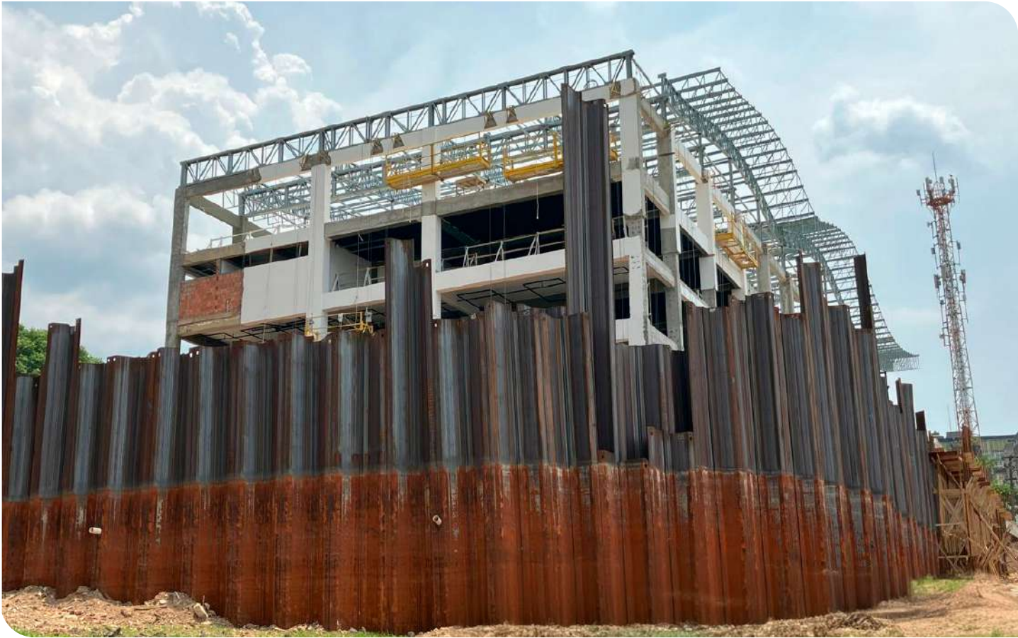
Contenção de margem Local: Manaus, AM Produtos: AZ ® 17-700
