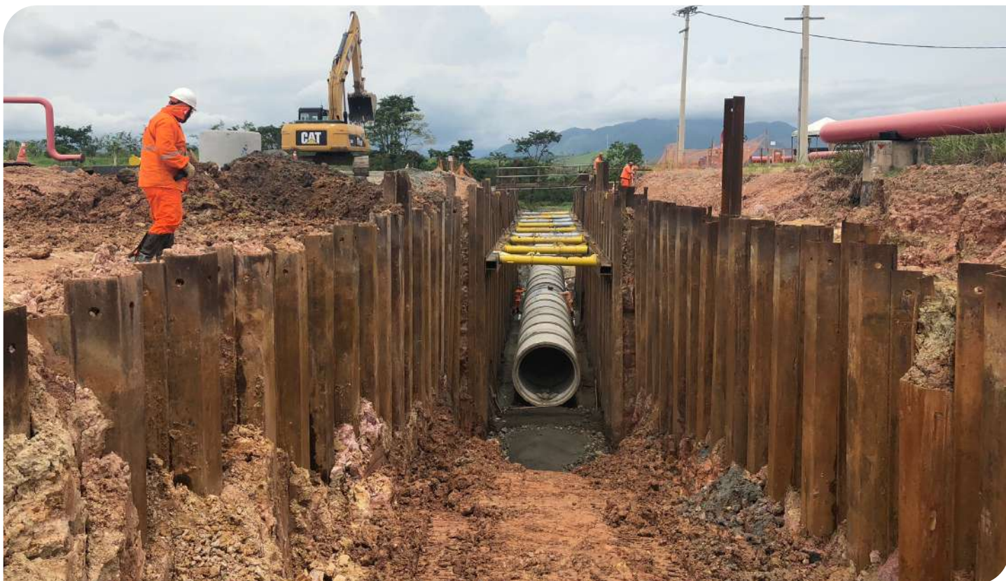
Escoramento de Vala Local: Itaboraí, RJ
