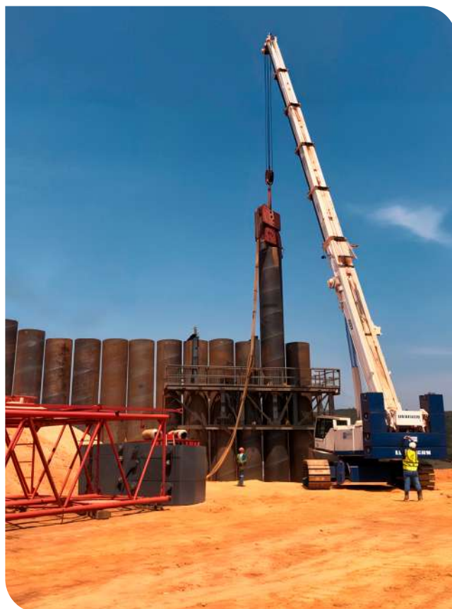
Martelo vibratório suspenso em guindaste
